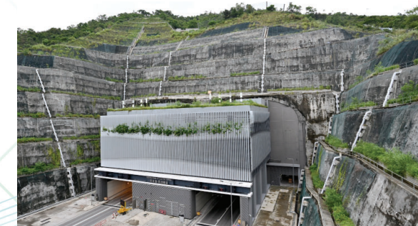
東通風大樓 East Ventilation Building
