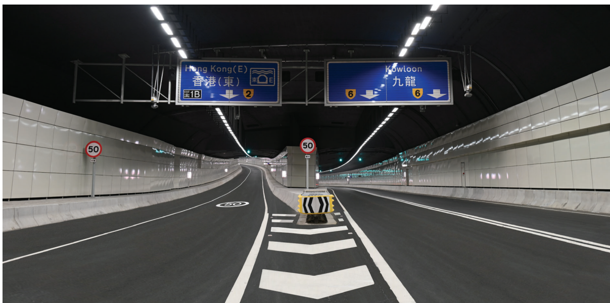
香港首條採用鑽爆法建造分支結構的隧道，跨度達38米
