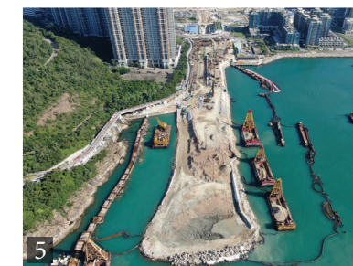
進行中的填海工程
