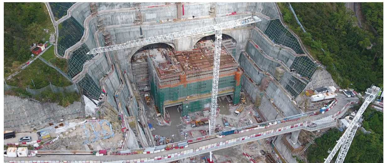
在岩洞內建造通風大樓 Construction of ventilation building in cavern
