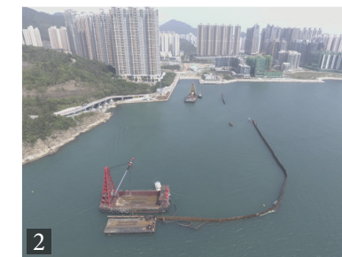
安裝臨時鋼圍堰
