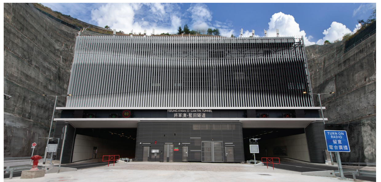
東通風大樓 East Ventilation Building
