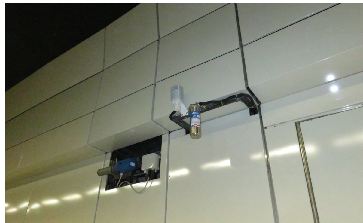
溫度感應器及一氧化碳過濾器 Temperature sensor & carbon monoxide filter
